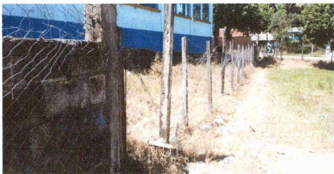
Foto 3: Mantenimiento de la cirulacion del centro educativo.
